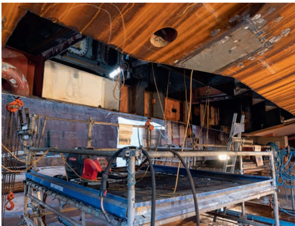
Une brèche a été réalisée dans la coque de la FLF Courbet afin de permettre l'installation du nouveau sonar de coque.
